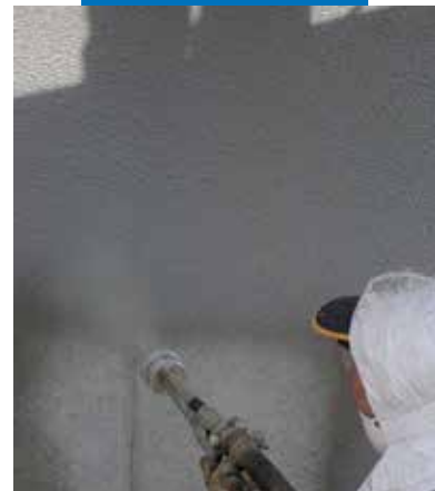
Påføring av Mapelastic med sprøyte på bru
